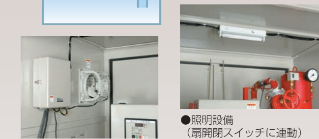
●換気扇 ヒータ、照明設備制御盤(別電源)
